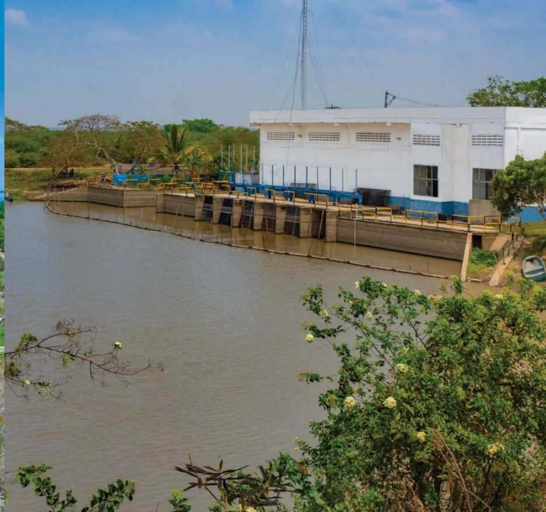
Estación de Bombeo de Agua Cruda Conejos
