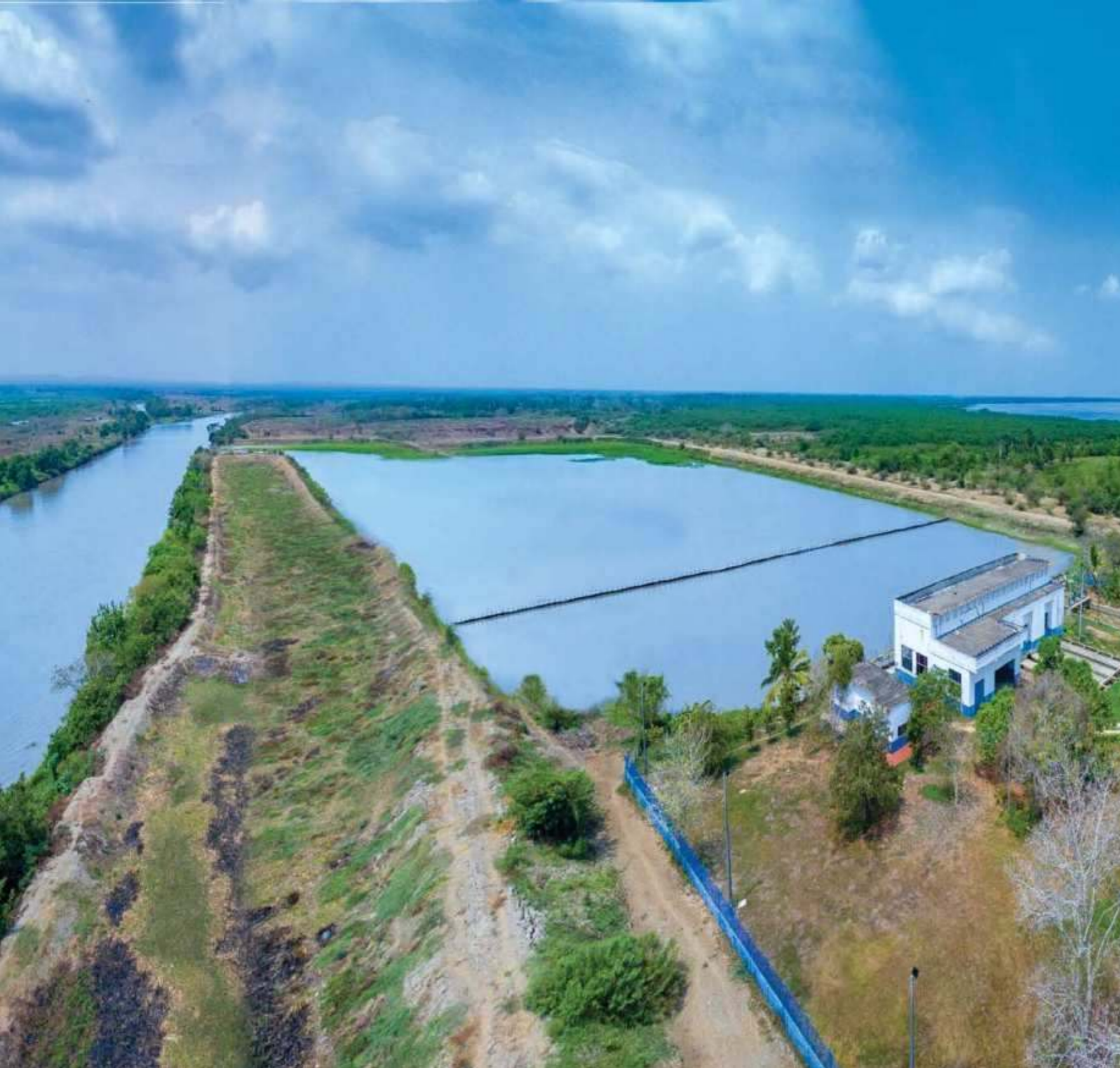
Estación de Bombeo de Agua Cruda Conejos
